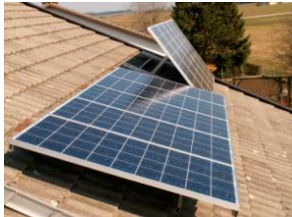
Der Neigungswinkel der Solarstromanlage ist verstellbar.
