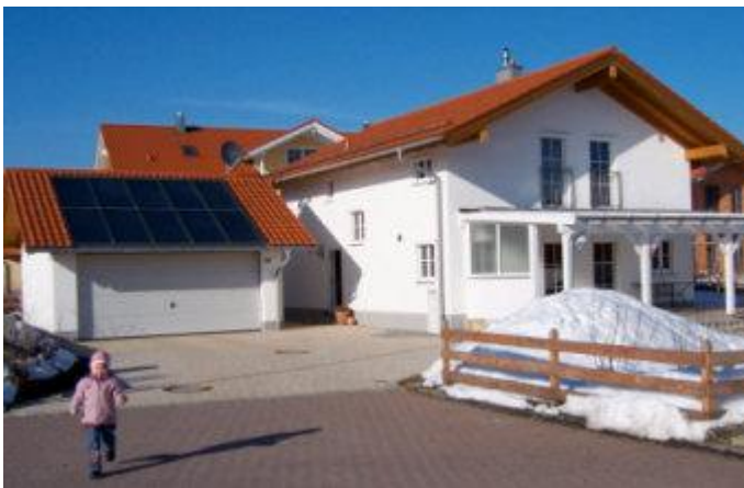
Das Garagendach mit der Kollektoranlage ist genau nach Süden ausgerichtet
