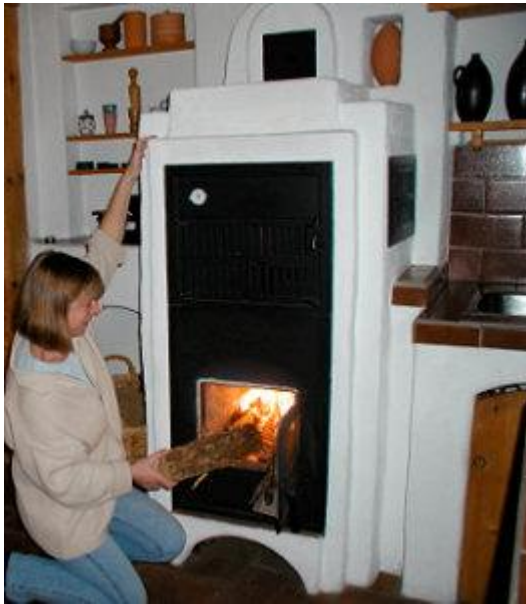
Der Zentralheizungs-Kachelofen dient neben dem Kollektor als Haupt-Heizquelle. Ein Großteil der Energie wird genutzt, um den Kombispeicher im Keller aufzuheizen. Von hier aus werden alle Räume mit Wärme versorgt.
