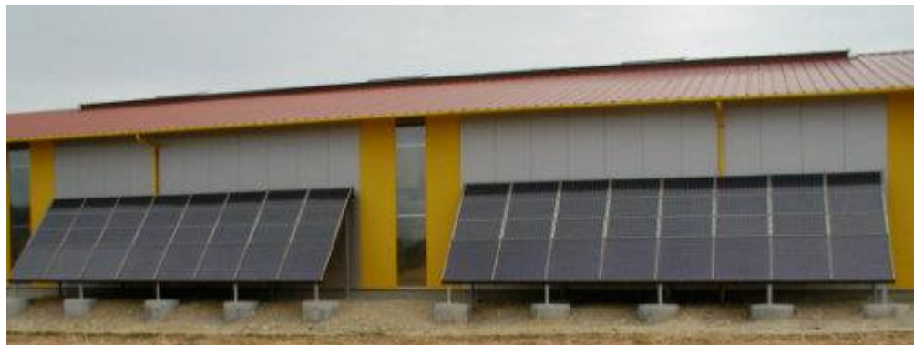
Die 65° geneigte Anlage in der Südansicht
