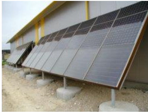
Die Fassadenanlage kurz nach dem Bau: Untere Hälfte Hochleistungsflächenkollektor, oben rahmenlose PV-Module
