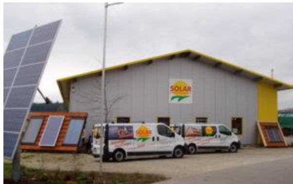
Die zweiachsig nachgeführte PV-Anlage, dahinter ein Kollektor-Versuchsstand.
