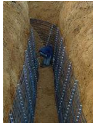
Platzsparend: Der ca. 20 m lange Grabenkollektor bei der Verlegung
