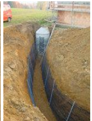
Platzsparend: Der ca. 20 m lange Grabenkollektor bei der Verlegung
