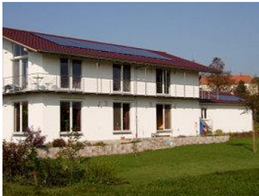
Ein Haus ganz ohne Kamin – hier die Südansicht mit dem 10 m² Hochleistungsflächenkollektor auf dem Garagendach und der Solarstromanlage auf den Hausdach
