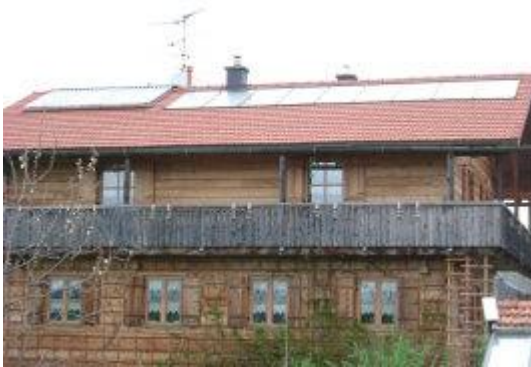
Die bestehende Vakuum-Röhrenkollektoranlage wurde mit 18 m 2 Hochleistungsflächenkollektor erweitert.
