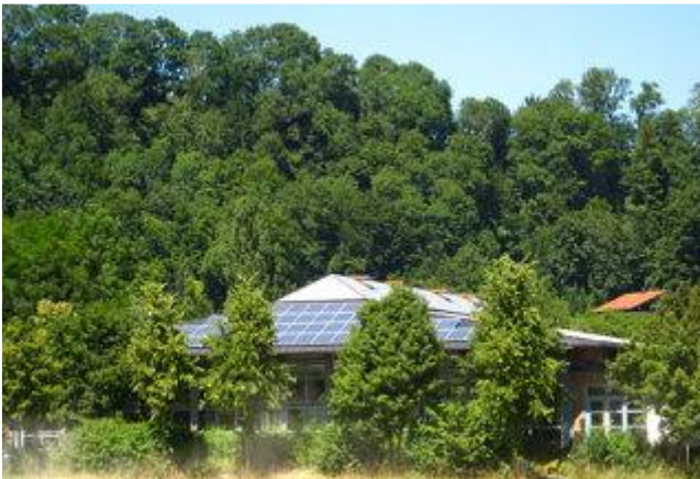
Ein Blick auf das Süddach: Die Module fügen sich schön in die Dachlandschaft ein.
