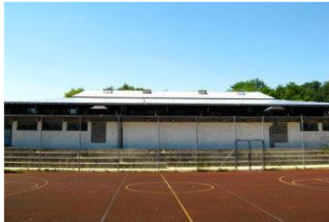
Auch von der Ostseite aus betrachtet wirkt die Solarstromanlage nicht störend.
