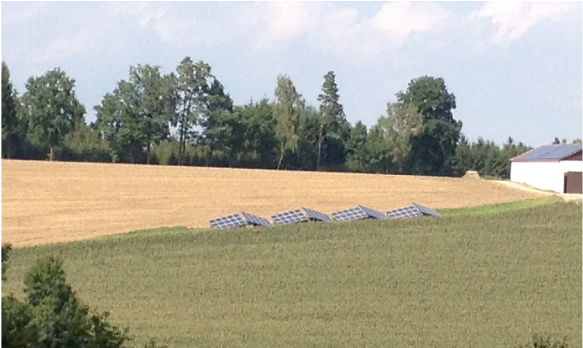
Gerade kann jeder: Die 30 kW Anlage an einer Böschung. Im Wald im Bild oben sind die Brunnen und der Hochbehälter.
