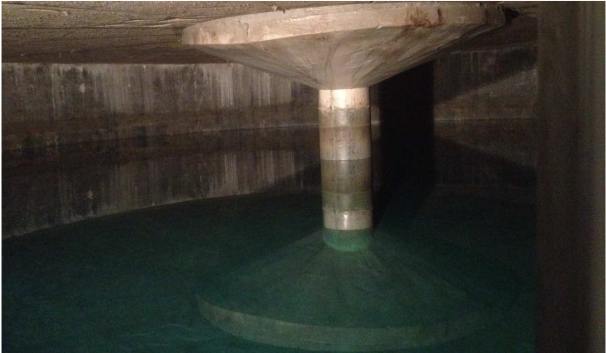
Blick in den Hochbehälter.
