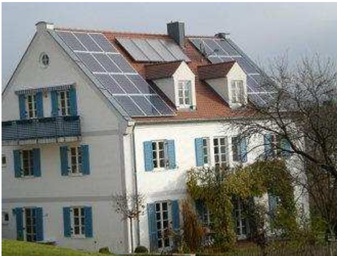
Die Solarstromanlage wurde in zwei symmetrischen Hälften montiert. Die Kollektoranlage zur Brauchwassererwärmung war vorhanden.
