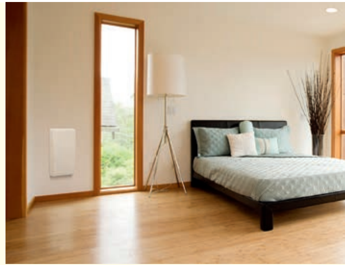
Effizient und vielseitig: Die Halmburger Wohnraumlüftung im eingebauten Zustand (unter Putz).
