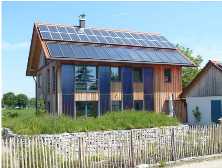
Anlagenkonzept und Haustechnik des Sonnenhauses in Unterhaching stammen von Solar-Partner Süd GmbH aus Kienberg.
