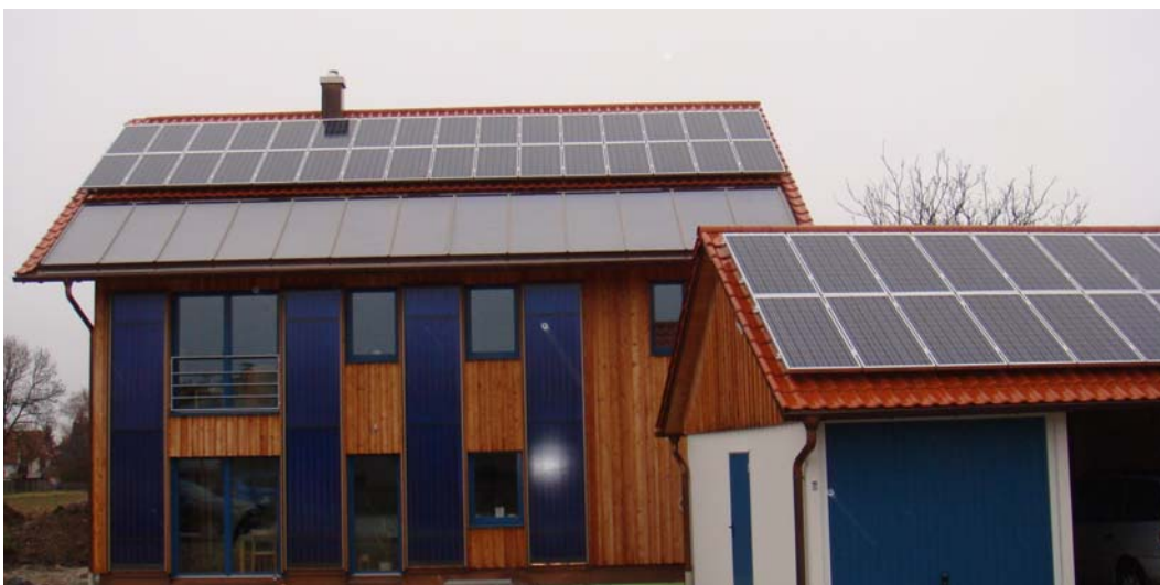
Maßgeschneidert: Dach- und fassadenintegrierte Kollektoranlage von Solar-Partner Süd
