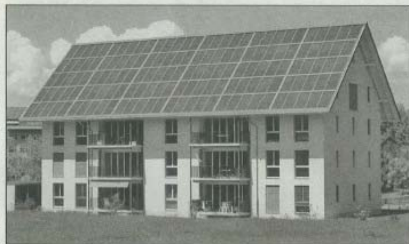
Europas erstes zu 100 Prozent mit Sonnenenergie beheiztes Mehrfamilienhaus in Oberburg erhält Zuwachs.
