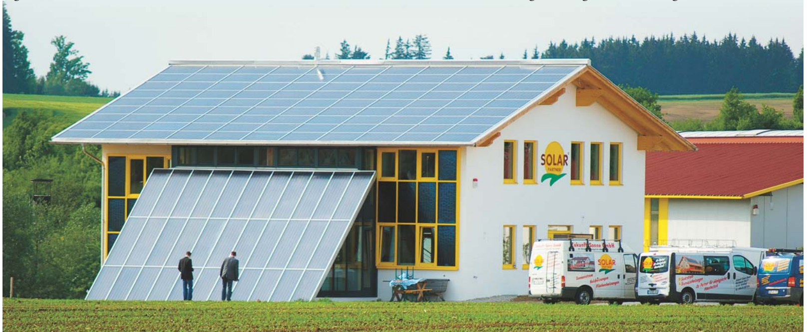
Jeder Quadratmeter Südseite des Gebäudes in Kienberg wird zur solaren Energiegewinnung genutzt.
