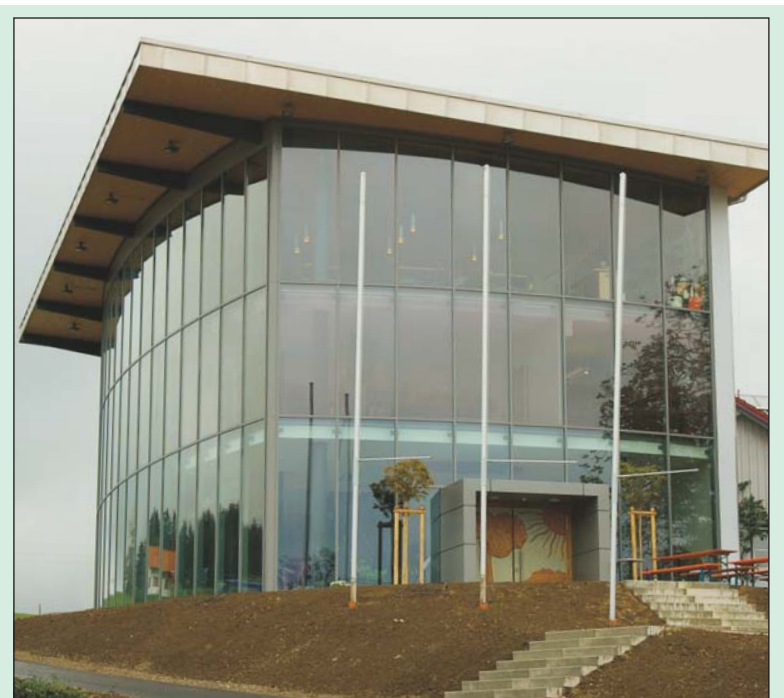
Das neue Betriebsgebäude von Rennergy in Buchenberg hat trotz 450 Quadratmetern Glaswänden einen sehr niedrigen Heizwärmebedarf.
