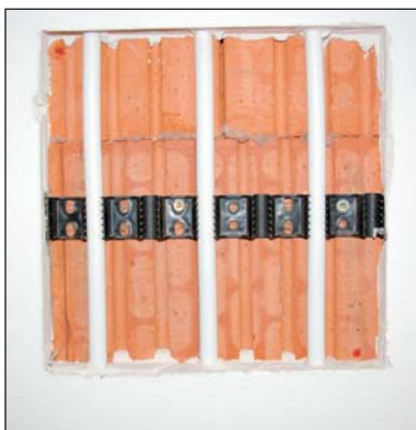
Durch Sichtfenster in der Wand und im Boden können die verschiedenen Flächenheizsysteme gezeigt werden.
