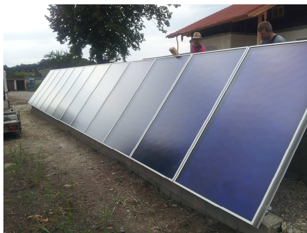
Die 12 OmniSol A Kollektormodule wurden auf einem stabilen Fundament aufgeständert.
