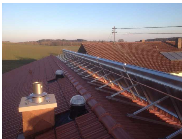
Stabile Befestigung mit Alu-Profilen. Im Hintergrund die bestehende Anlage.
