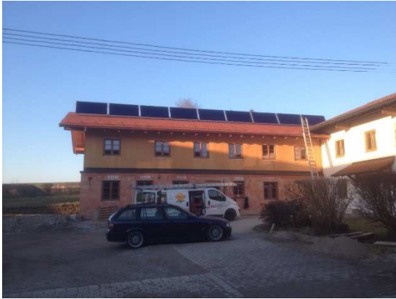
Ein Blick auf das Süddach.
