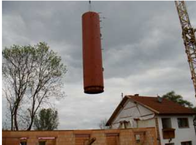
Einbringung des 16.600 l großen Pufferspeichers mit 1,70 m Durchmesser und ca. 7,70 m Höhe. Der Speicher mit dreistufiger Solarbelastung wurde zentral im Gebäude eingehaust und mit Mineralfaser-Einblasdämmung isoliert.
