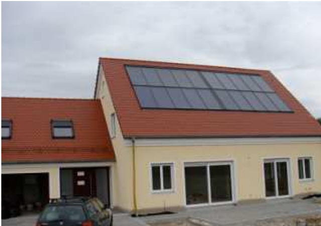
Die Südansicht kurz vor dem Einzug. Der 45 m 2 große dachintegrierte Hochleistungsflächenkollektor nimmt den größten Teil der Dachfläche ein.
