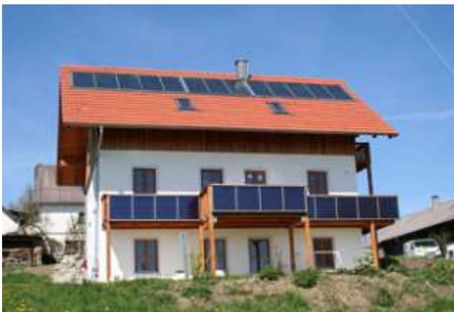
Die Südansicht des Gebäudes: Zur Vergrößerung der Kollektorfläche wurde ein Teil an die Balkonbrüstung gesetzt.
