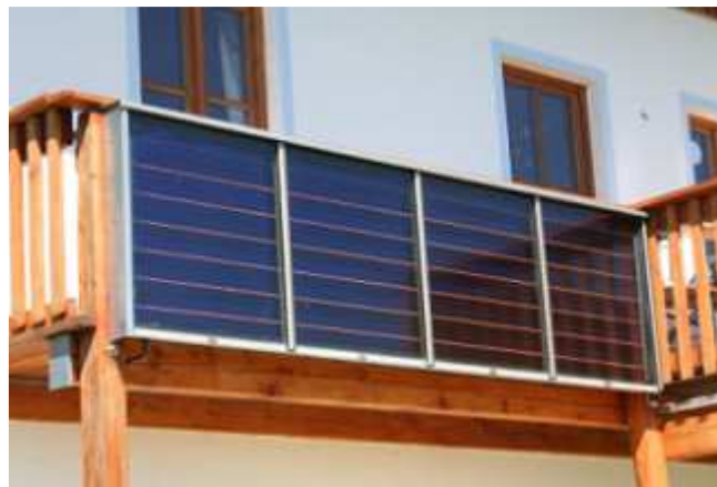
Zwei Fliesen mit einer Klappe: Der Kollektor dient gleichzeitig als Balkonbrüstung.
