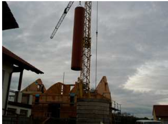
Koloss: Der ca. 15.700 l SWISS-SOLARTANK mit 1,50 m Durchmesser und 9 m Höhe wurde mit dem Baukran ins Treppenhaus eingehoben.
