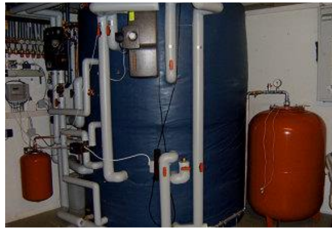
Der 3.120 l große Pufferspeicher mit 1,40 m Durchmesser wurde in 4 Teilen geliefert und vor Ort geschweißt. Der fertig bestückte Speicher wurde mit einer extra starken Wärmedämmung versehen.
