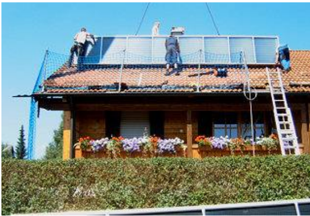
Die Großflächen-Kollektormodule wurden mit Hilfe eines Autokrans montiert.
