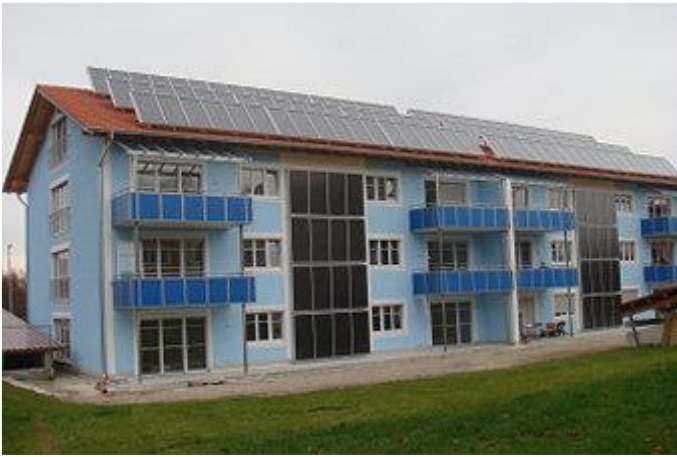
Das Solarhaus besteht aus zwei identischen Hälften mit je 6 sehr komfortablen, hellen Wohnungen. Die hohen Fenster verleihen dem von Dipl.-Arch. Hermann Mayer entworfenen Gebäude eine ästhetische Stadthaus-Architektur.
