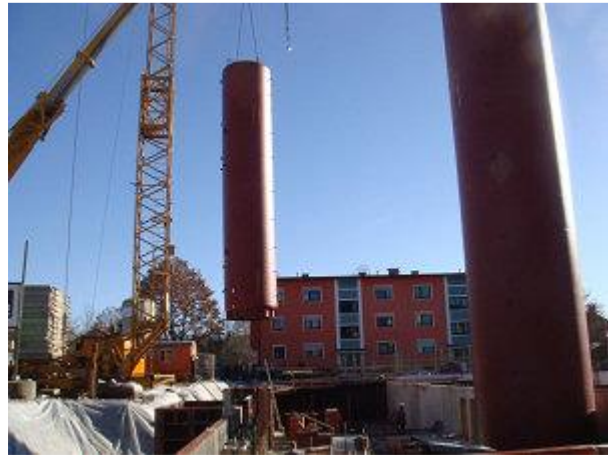
Die beiden Großspeicher mit ca. 77.000 l wurden vor Fertigstellung der Kellerdecke auf die Bodenplatte gehoben. Das Haus wurde regelrecht um die Speicher herum gebaut.
