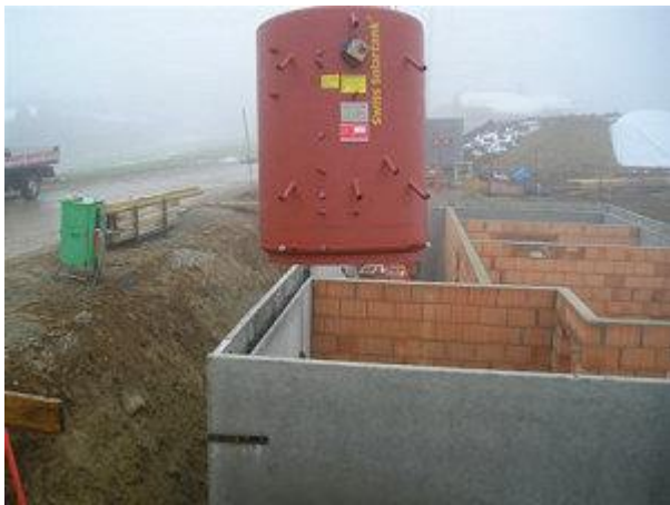
Dicker Brummer: Bilder von der Speichereinbringung. Große Pufferspeicher müssen vor Verschließen des Gebäudes bzw. vor Aufbringen der Kellerdecke mit einem Kran eingebracht werden
