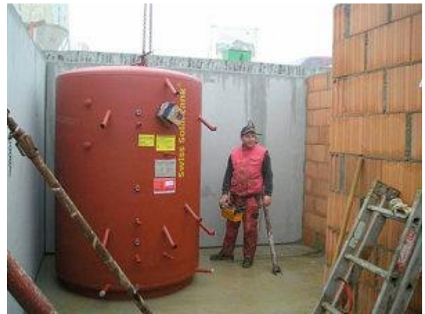
Dicker Brummer: Bilder von der Speichereinbringung. Große Pufferspeicher müssen vor Verschließen des Gebäudes bzw. vor Aufbringen der Kellerdecke mit einem Kran eingebracht werden
