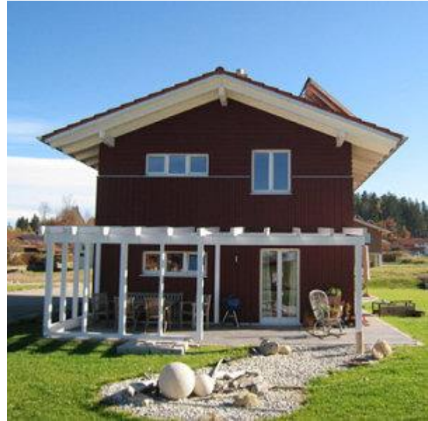
Durch den roten Anstrich erhält das Haus in Holz-Massivbauweise ein skandinavisches Flair. Von der Straße aus ist die Kollektoranlage nicht zu sehen.
