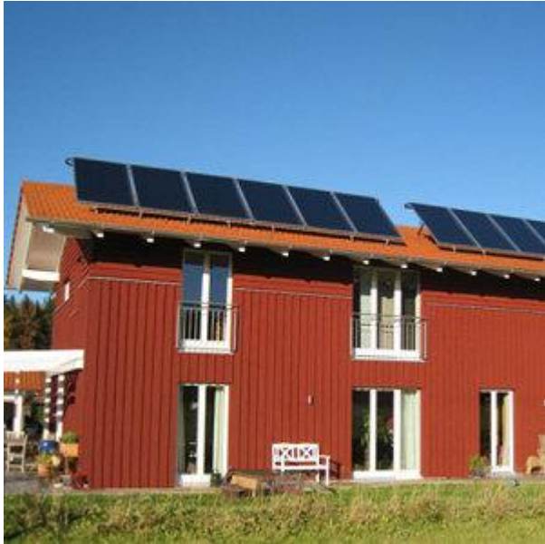
Für das neue Baugebiet oberhalb Traunstein wurde bereits im Bebauungsplan die Aufständigung von Kollektoranlagen ausdrücklich freigestellt.
