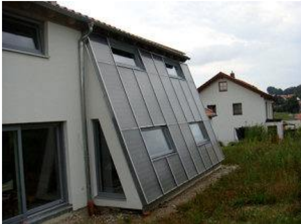
Futuristisch wirkt die schräg gestellte Fassade. Die Fenster wurden in die Kollektoranlage nahtlos integriert.
