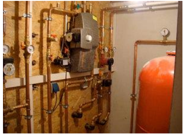
Der 3 m hohe SWISS-SOLARTANK wurde mit einer Trockenbau-Einhausung verkleidet und mit Zellulose wärmedämmt. Die Einhausung dient gleichzeitig als Installationswand.
