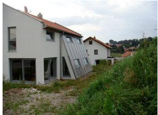
Solararchitektur ist breit gefächert. Häuser mit Schrägfassade werden uns in Zukunft vermutlich öfter begegnen.
