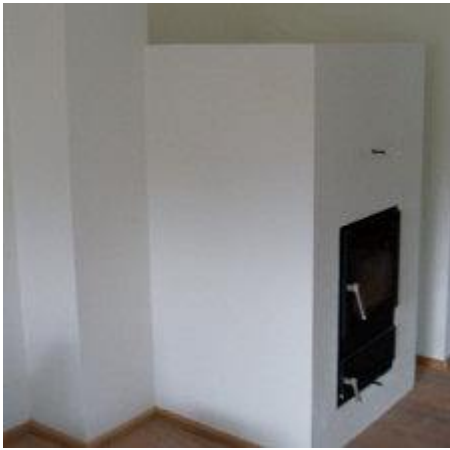
Gerdadlinig und schlicht wurde die Einhausung des POWALL OFKA ZentralheizungsOfens gestaltet. Der Ofen mit großer Sichtscheibe heizt in der Kernzeit des Winters den Pufferspeicher nach – und wärmt die Seele..
