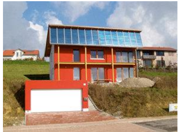
Die Südansicht: Architektur und Farbgebung heben das sehr modern gehaltene Gebäude von seiner Umgebung ab.
