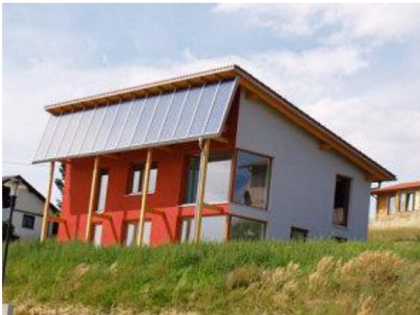
Durch und durch ein konsequentes Sonnenhaus: Der Kollektor ist mit einem Neigungswinkel von 75° optimal für die Wintersonne ausgerichtet.
