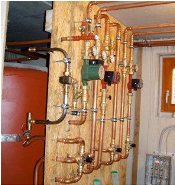
Während der Rohmontage: Der im Boden teilweise versenkte Speicher verschwindet hinter der Installationswand. Der komplette Hohlraum wird mit Zellulose-Wärmedämmung ausgeblasen.
