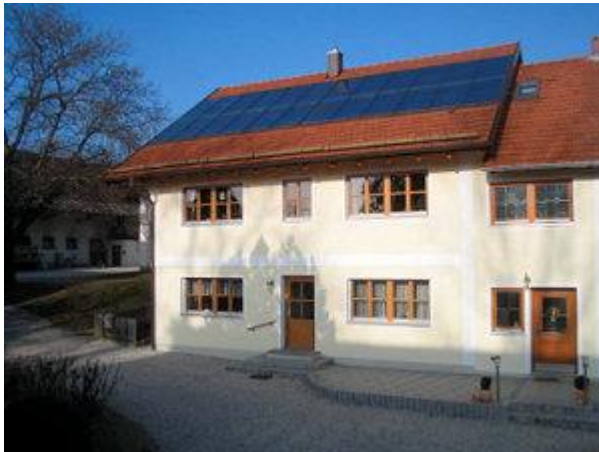
Das neu errichtete Bauernhaus mit 48 m 2 Kollektorfläche entspricht Sonnenhausstandard.
