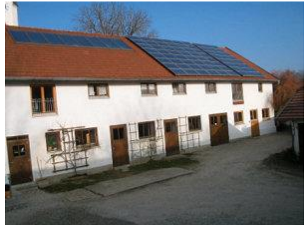
Das ehemalige Stallgebäude wurde mit 4 Wohnungen ausgebaut, zusätzlich befindet sich hier der 200 m 2 Wirtschaftsraum. Die 16 m 2 Kollektoranlage dient zur Warmwasserbereitung, rechts die 7,2 kW PV-Anlage.
