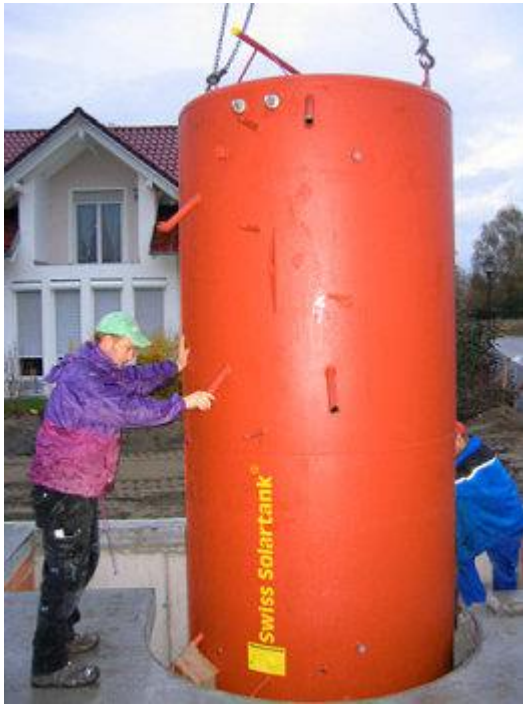
Der SWISS-Solartank wurde mittels Kran in das Gebäude eingebracht.
