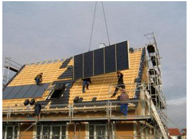
Ein Bild von der Kollektormontage.
