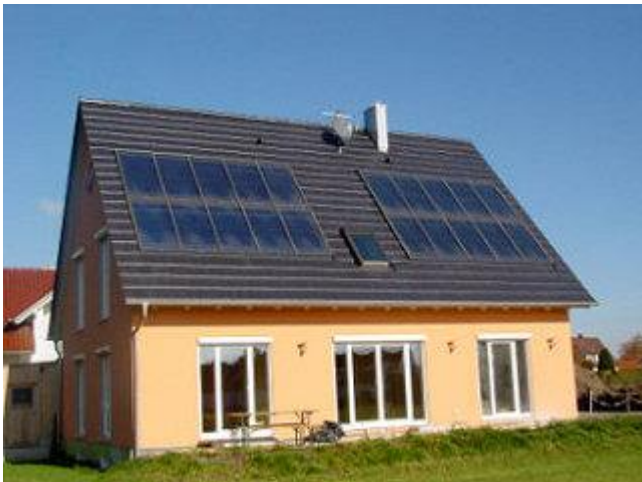
Die 40 m 2 Kollektoranlage ist auf zwei Hälften im Format b x h = 5 x 4 m aufgeteilt.
