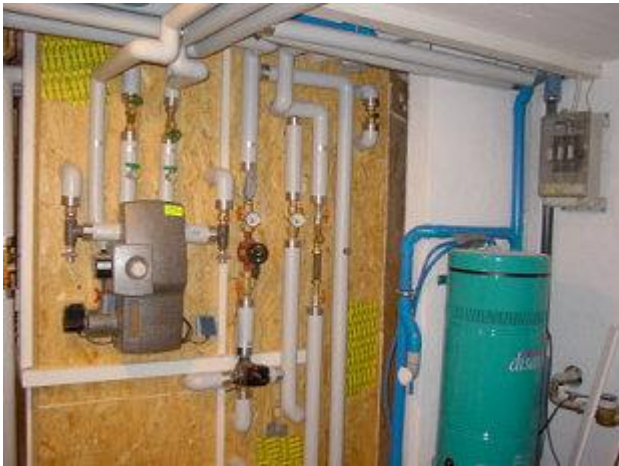
Hinter der Installationswand befindet sich der 6.000 l Pufferspeicher. Damit der 3,50 m hohe Puffer Platz findet, wurde die Bodenplatte an dieser Stelle vertieft. Der Speicher wurde in mehreren Teilen eingebracht und vor Ort geschweißt.
