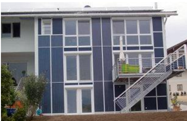
Die neu gestaltete Südfassade: In die Holz-Glas-Fassade wurden 23 m 2 Kollektor integriert. Auf dem Dach wurden ca. 21 m 2 Modulkollektoren aufgeständert und eine 4,55 kW PV-Anlage montiert.
