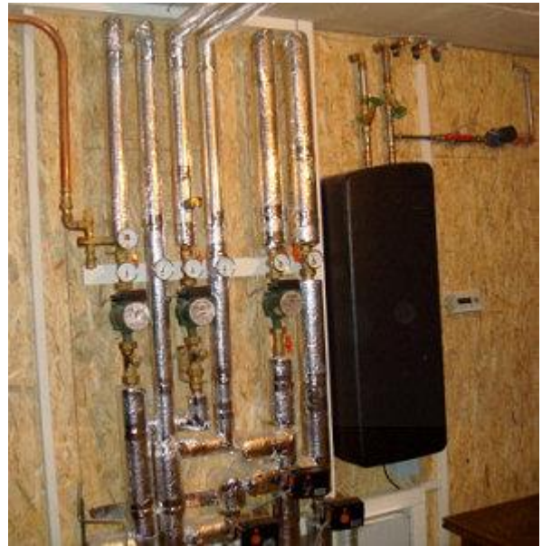
Pufferspeicher und Installationswand während und nach der Montage. Der komplette Hohlraum wurde mit Zellulosewärmedämmung ausgeblasen.
