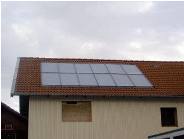
Da das Wohnhaus kein geeignetes Süddach aufweist, wurde die 24 m 2 Kollektoranlage auf dem Dach des Nebengebäudes integriert.
