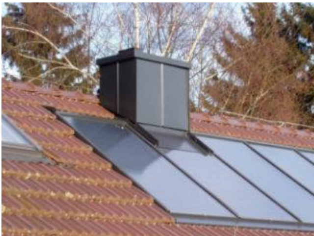
Maßgeschneidert: Der Kaminkopf wurde bei diesem Hochleistungsflächenkollektor ausgespart
