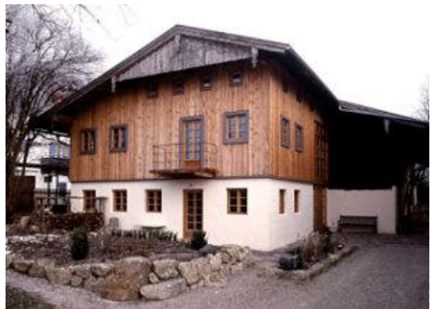
Die Naturstein-Außenwände im EG wurden erhalten und neu verputzt. Die Temperierung mit einer Wandflächenheizung sorgt für behagliches Klima.
