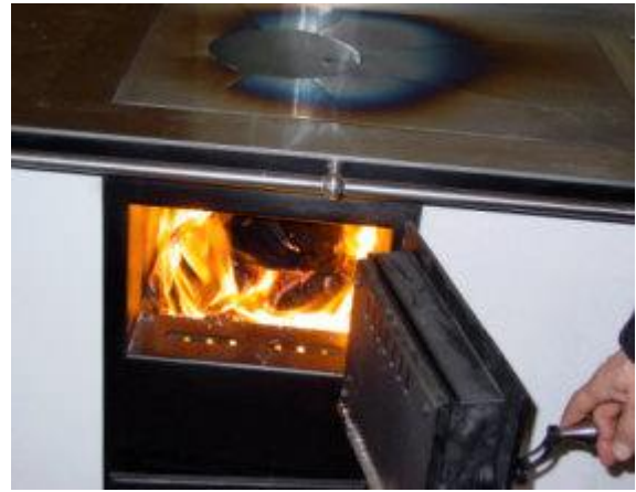
Effiziente Verbrennung: Der POWALL-Heizherd arbeitet nach dem Holzvergaserprinzip und speist den größten Teil der Wärme in den über 3.000 l großen Pufferspeicher.
