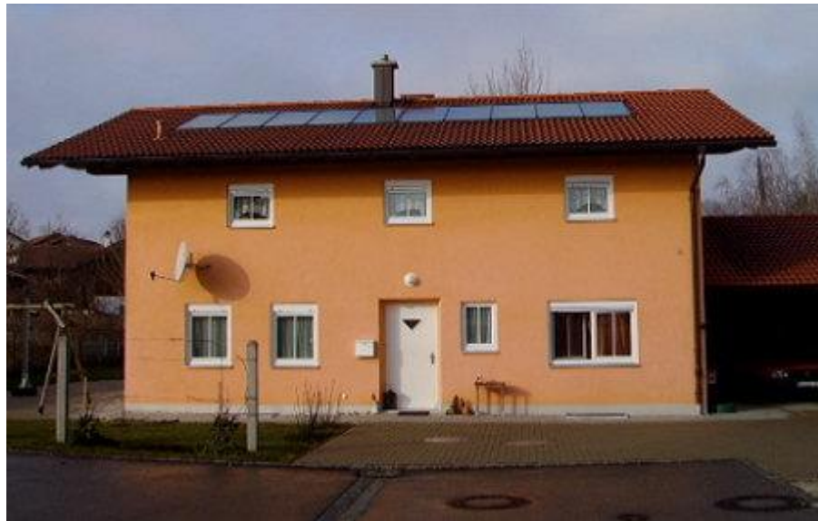
Der Hochleistungsflächenkollektor fügt sich schön in das Gebäude ein. Für die Solarenergienutzung wäre eine steilere Dachneigung vorteilhaft.
