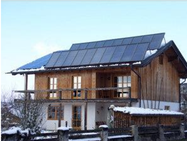
Optimale Neigung: Da das Dach zu flach ist, wurde die 40 m 2 große Kollektorfläche in zwei Reihen aufgeständert
