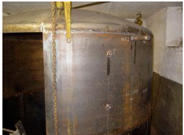
Wie in einer Schiffswerft: Der 14.000 l große Puffer mit 2,50 m Durchmesser wurde im Keller geschweißt
