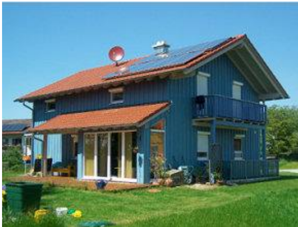
Eine Schmuckstück: Das Einfamilienhaus in Holztafelbauweise wurde in Eigenleistung ausgebaut
