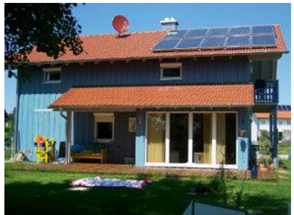
Die Aufdach-Kollektoranlage besteht aus 10 Modulen mit je 2,1 m 2 Bruttofläche
