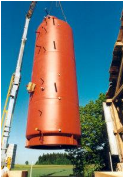
Der SWISS-SOLAR-Großspeicher wurde mit Hilfe eines Autokrans in das Gebäude eingebracht.
