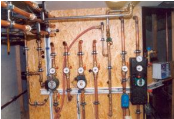
Ein Blick in den noch unfertigen Technikraum.
