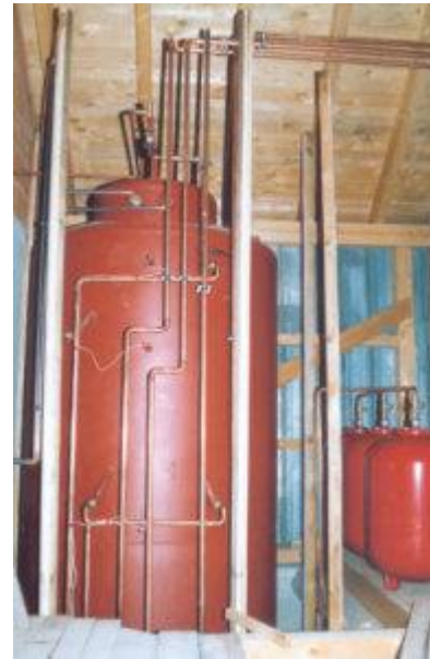
Der Speicher reicht über zwei Etagen und versorgt auch den Altbau mit Heizenergie und Warmwasser.
