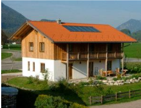
Die Südsicht mit der 12 m 2 Kollektoranlage. Leider lässt die Baubehörde in den Voralpengemeinden keine steilere Dachneigung zu.
