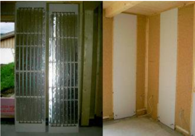
Die Sonnenwand-Heizpaneele vor und nach dem Einbau. Die Verrohrung erfolgt nach der Befestigung im Bodenaufbau.
