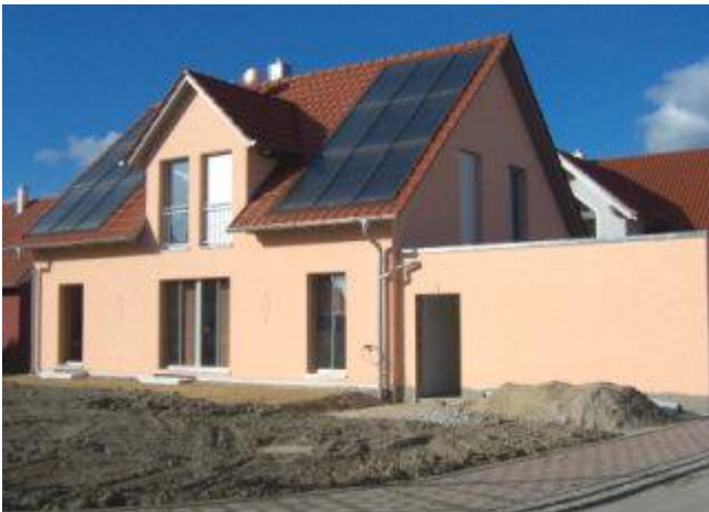
Die Kollektoranlage besteht aus zwei Feldern mit je 18 m 2 , beidseitig der Gaube angeordnet. Die Dachneigung beträgt ca. 50°
