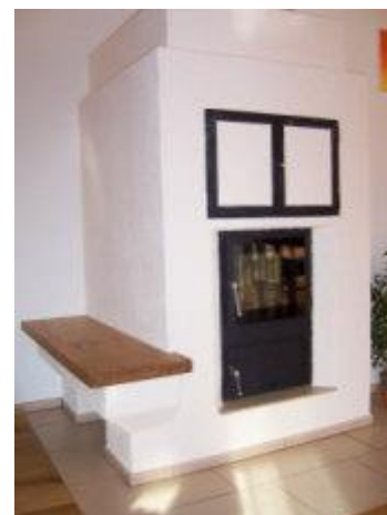
Einzige Nachheizquelle ist der POWALL Vario K Zentralheizungsöfen, der im Wohnzimmer steht.
