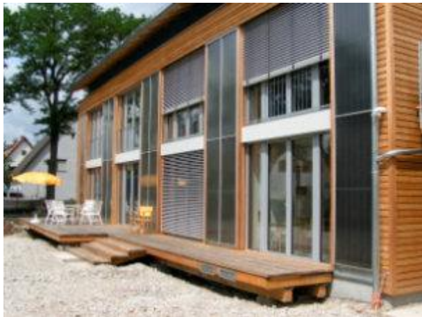
Aktive und passive Sonnenenergienutzung: Der Fassadenintegrierte Großflächenkollektor fügt sich gut ein ergänzt die großzügige Verglasung auf der Südseite.
