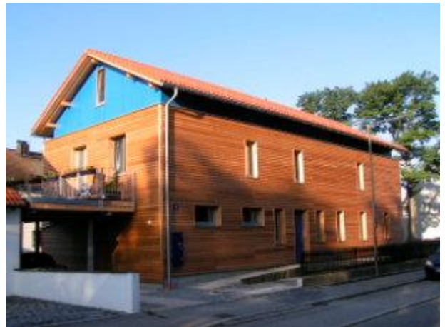
Ein Blick von der Straße auf die Nordseite des Gebäudes.
