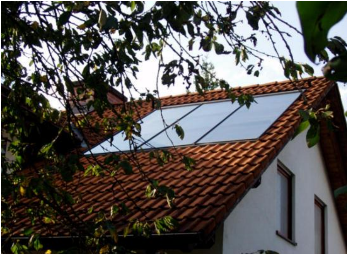
Klein aber fein – Kollektor mit 3 m hohen Sonderformat-Gläsern.
