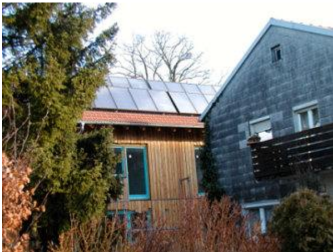
Südansicht mit dem aufgeständerten Großflächenkollektor. Das alte Wohnhaus rechts wird demnächst abgerissen.
