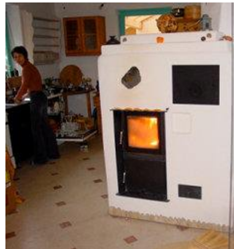
Der POWALL-Ofen mit Back- bzw. Warmhaltefach und Kesselteil dient als Nachheizung.
