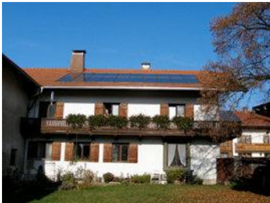
Der 40 m 2 große Hochleistungsflächenkollektor auf dem Bauernhaus fügt sich schön ein.
