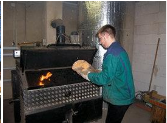
Beim 40 kW LOPPER Stockholzkessel mit großem Füllraum und Befüllung von oben (Toplader) kann mit 1 m langen Scheiten geheizt werden.
