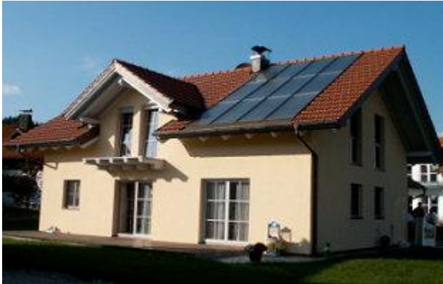
Südansicht mit dem 4 x 6 m großen Hochleistungsflächenkollektor.
