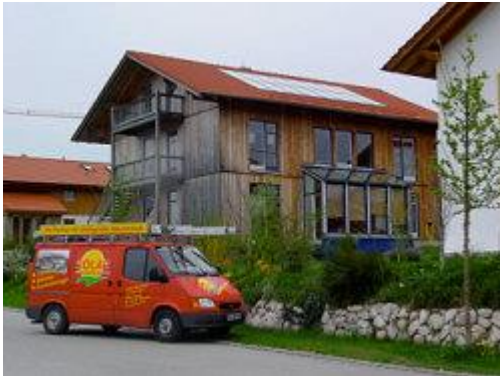
Der 32 m 2 Hochleistungsflächenkollektor deckt den Heizenergiebedarf etwa zur Hälfte ab. Große Glasflächen auf der Südseite bringen zusätzlich passive Wärmegewinne.
