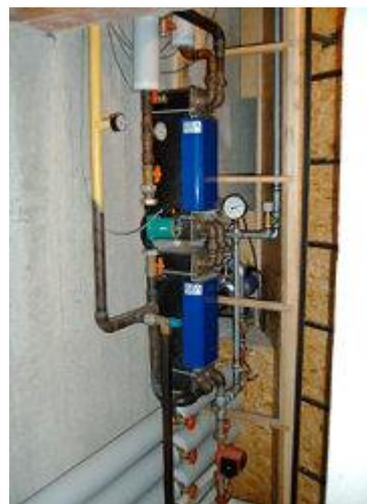
Zwei in Serie geschaltete großdimensionierte Plattenwärmetauscher beladen den Speicher im Low-Flow-Prinzip
