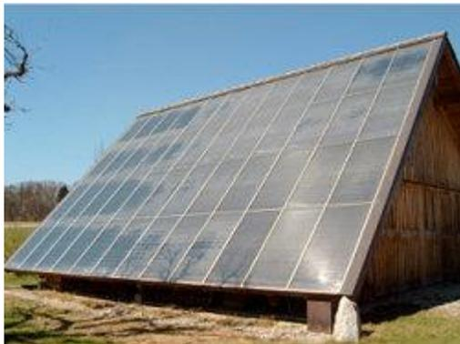
Imposant: 96 m<sup>2</sup> Kollektorfläche bilden das Süddache der Maschinenhalle
