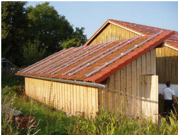
Für die Wechselrichter wurde eigens ein kleines Technikhaus gebaut. Auch das Dach des Technikraums wurde für die Solarstromanlage genutzt.
