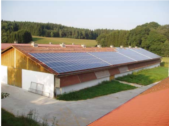
Der größte Teil der Module wurde auf zwei Putenställen montiert.
