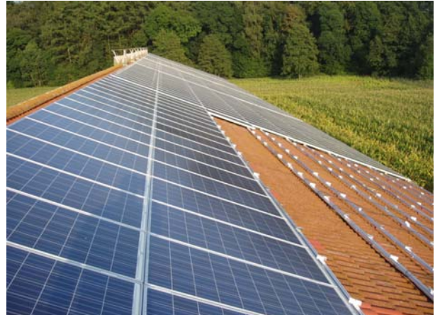
Ein Bild während der Montage – mittlerweile ist jeder verfügbare Quadratmeter Dachfläche mit Modulen belegt.
