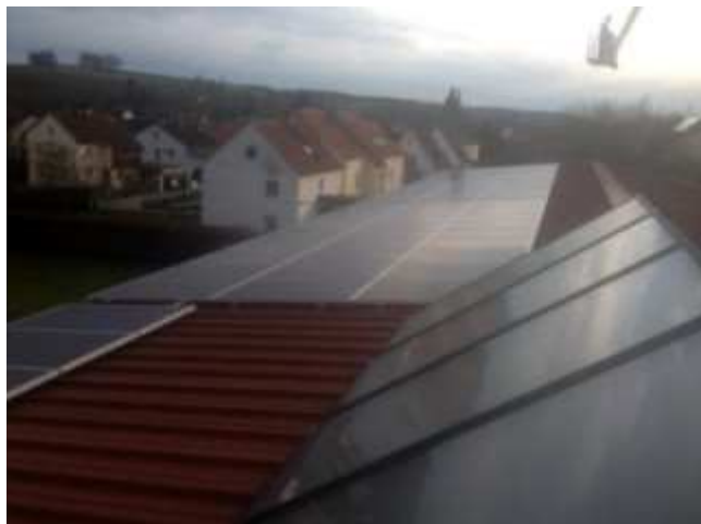
Im Vordergrund die Brauchwasserkollektoren Die Module in der Abendsonne
