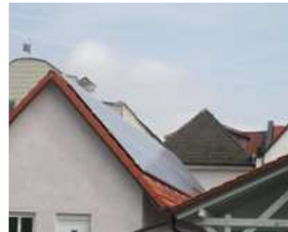
Die Anlage auf dem hinteren neu angebauten Teil des Ladens.
