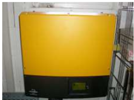
Der Wechselrichter hat seinen Platz im Lager gefunden.
