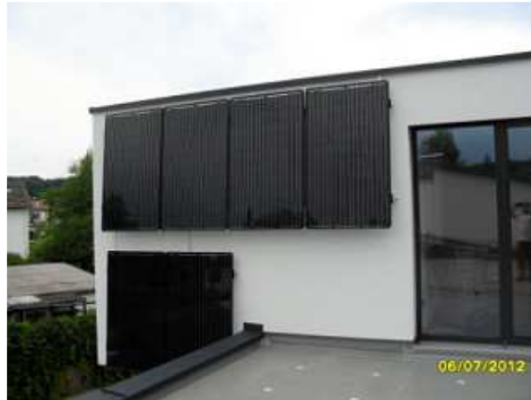
Eingepasst: Zwei der Fassaden wurden mit PV-Modulen bestückt.
