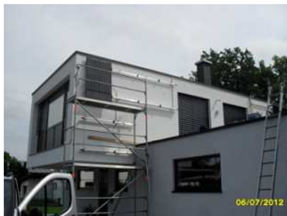
Die Fassaden-Module mussten einzeln vom Baugerüst aus montiert werden.
