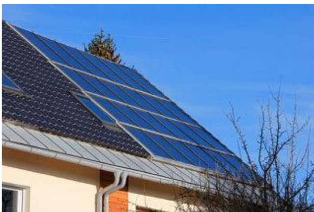
Der dachintegrierte Hochleistungsflächenkollektor belegt fast die gesamte Süddachfläche der Doppelhaushälfte.
